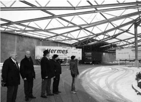
Besichtigung der BAUR-Einhausung
